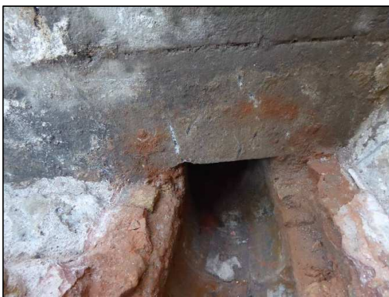
A l'esquerra entrada de UE 64 a l'interior del contrafort. A la dreta lloses de coberta de UE 64 a l'interior del contrafort. En tots dos casos sembla clar que la conducció és prèvia al contrafort.
