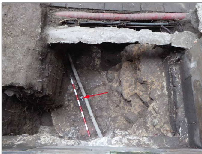
Vista de les dues conduccions superposades. La fletxa assenyala la posició de la conducció inferior de ceràmica.
