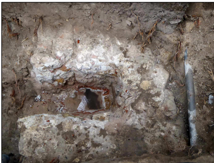
Vista de les dues conduccions documentades al sondeig 3. A la dreta el tub de plom i al centre l'estructura de protecció de morter de calç i pedres i la ubicació de la conducció ceràmica.
