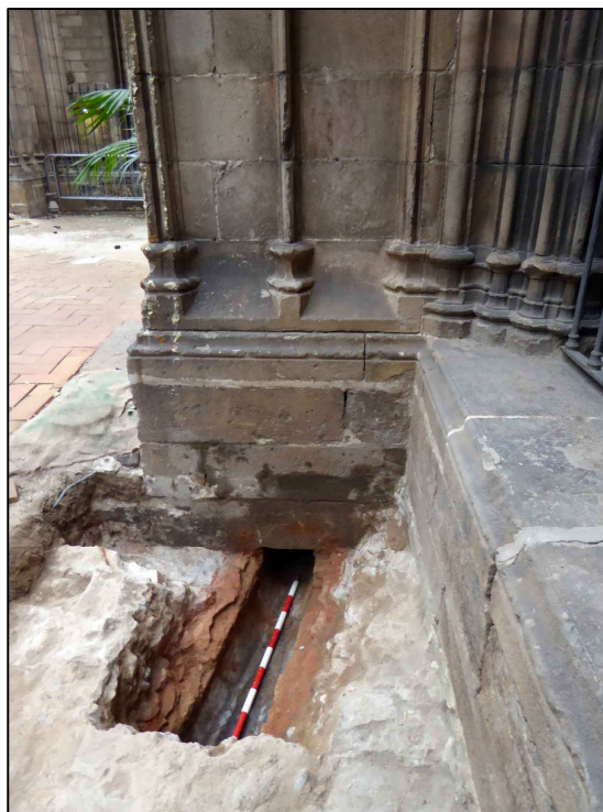
Vista del pas de la conducció de desguàs antiga per sota del contrafort del claustre.
