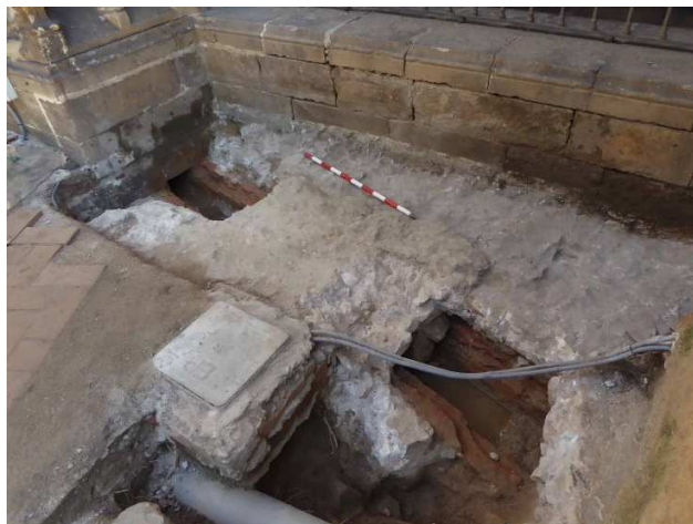
Vista general dels dos trams documentats de la claveguera UE 64.
