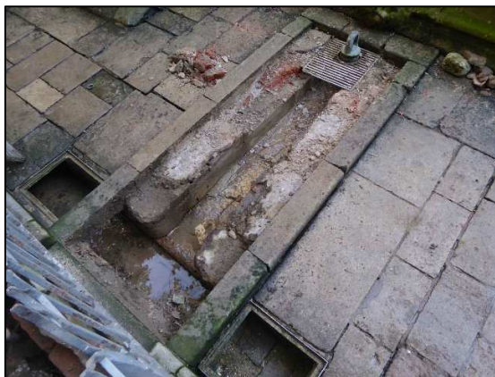
Vista de la canalització de desguàs de la bassa de les oques.
