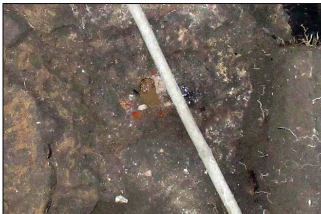
Vista de la conducció ceràmica UE 47
