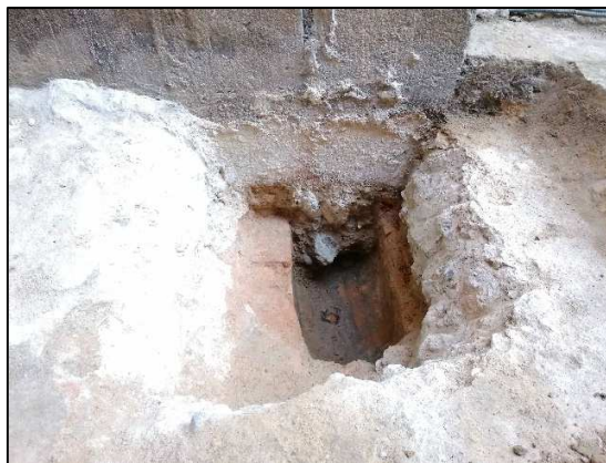
Vista de la conducció UE 64 localitzada en aquest punt.
