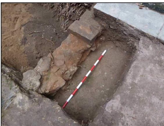
Vista superior del mur UE 83 i estrat UE 87
