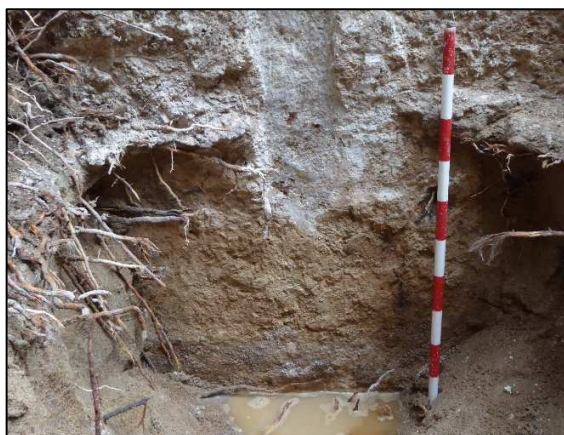
Vista del parament del mur UE 83. S'observa l'enlluït original de la paret per sota de la capa de calç de UE 84.
