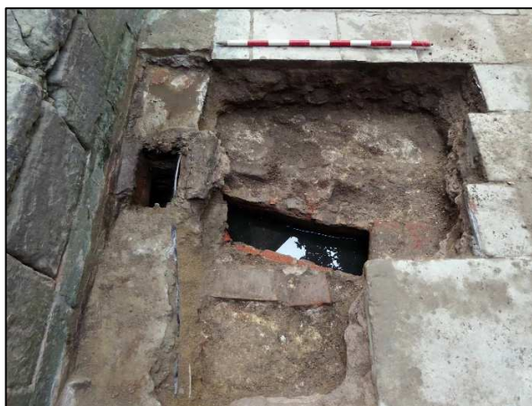
Vista de la canalització UE 11 i del registre inicial.
